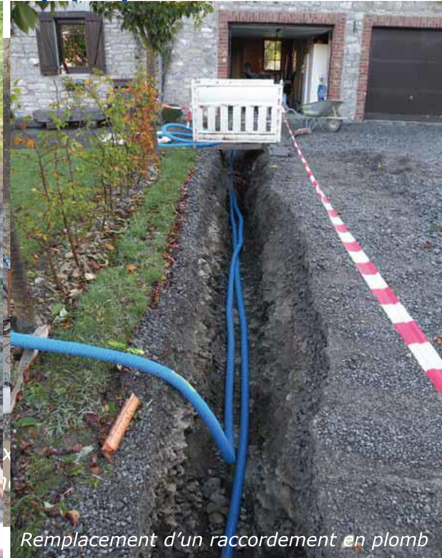
Remplacement d'un raccordement en plomb
