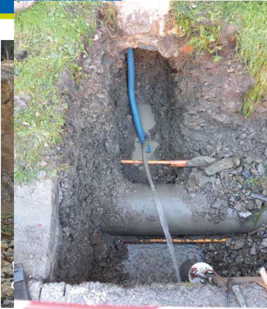
Remplacement d'un raccordement en plomb
