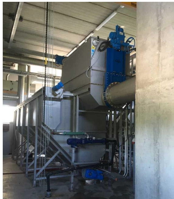
Joonis 3: Võreseedmed ja liivapüünised
