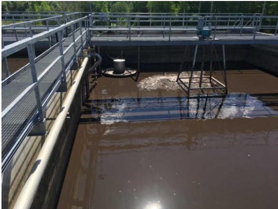
Joonis 4: Annusreaktor (SBR) seguri ja dekantriga
