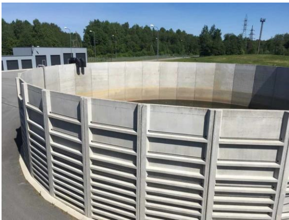
Joonis 11: Sademeveemahuti
