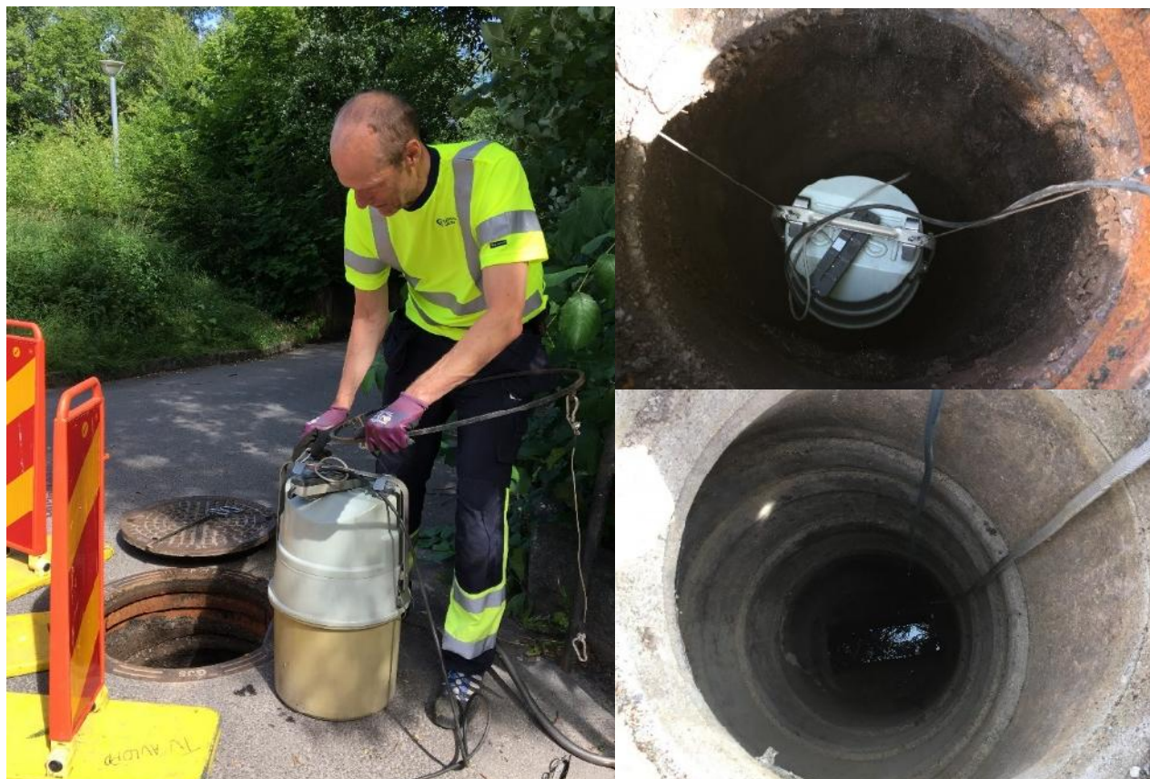
Haigla reovee proovi võtmine automaatse proovivõtuseadmega. Foto: Helene Ek Henning, CAB.
